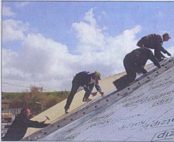
Auf dem Dach am Bahnhofsanbau wurde die Dampfsperre angebracht. Foto: mk
